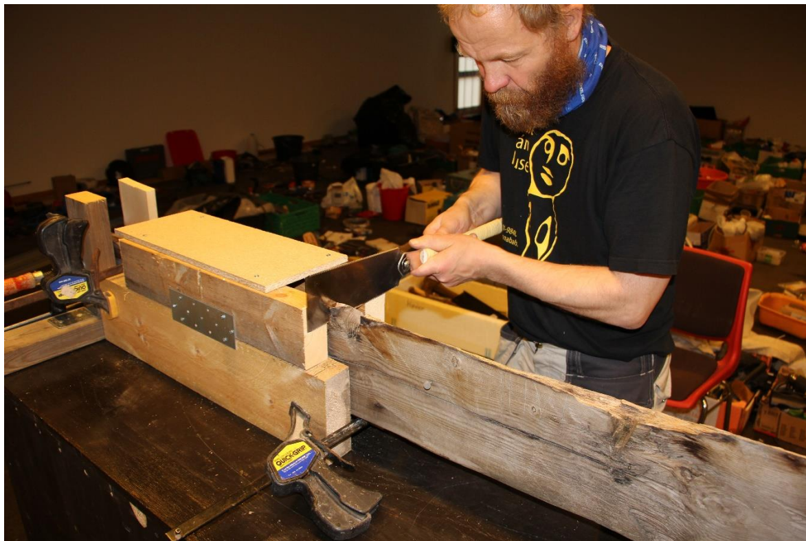
Restaurering av stabbur. Roger Persson bytter ut råteskadet tre i veggstokk med nytt trevirke. Foto: B.K. Olsen/VSM
